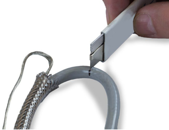
Abbildung A-32: Kabelummantelung einschneiden
