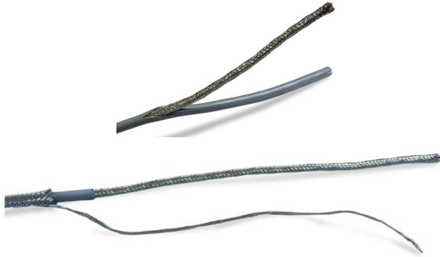
Abbildung A-34: Kabelummantelung vom inneren Schirmgeflecht abziehen
