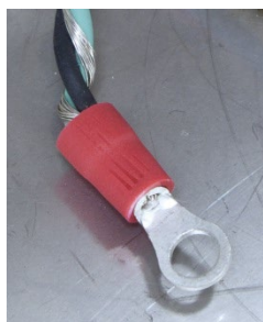
Abbildung A-52: Abschluss der Erdungsader
