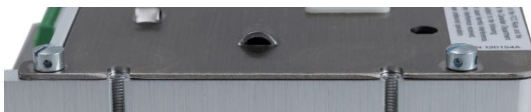
Figura 2-127: Tornillos de sellado instalados
